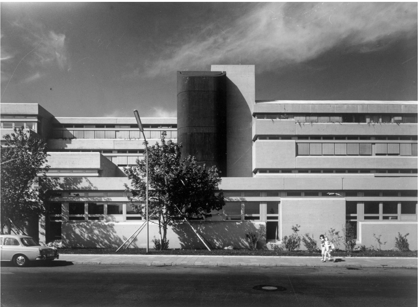
Abb. A: Bauzeitliche Ansicht (Foto: Sigrid Neubert, um 1975)
